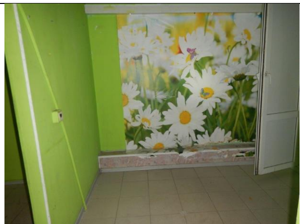
Фото 10. Внутреннее состояние Объекта оценки
