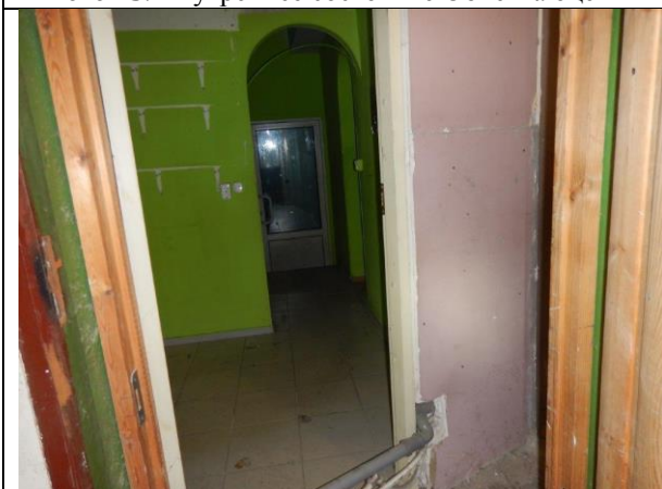
Фото 15. Внутреннее состояние Объекта оценки
